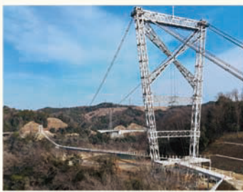
▲日本最長の歩行者専用つり橋 GODA BRIDGE
